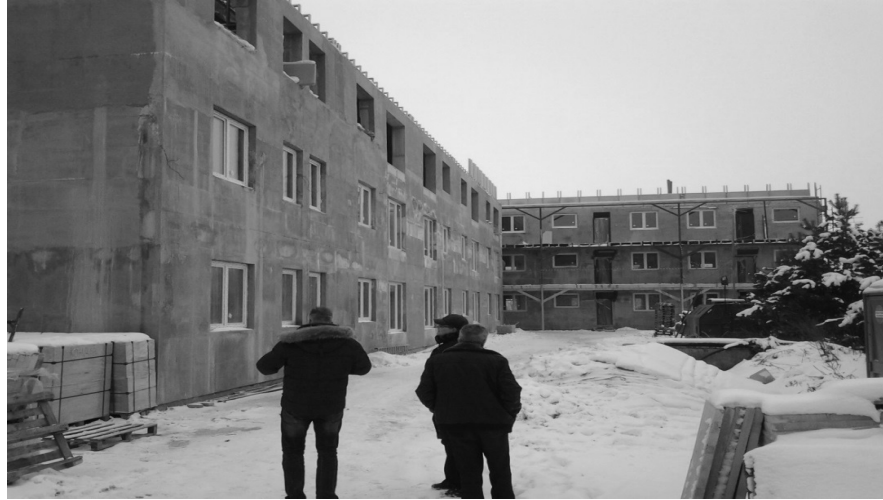
صورة 5: مباني من ثلاثة طوابق باستخدام ألواح خفيفة من خرسانة النانو مصبوب داخلها خرسانة النانو ومركبة على هيكل معدني خفيف للأسقف والحوائط في مناطق باردة
