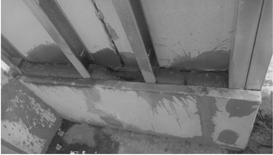
صورة 3: تبين الحوائط المركبة من ألواح خرسانة الناتو أثناء التركيب
